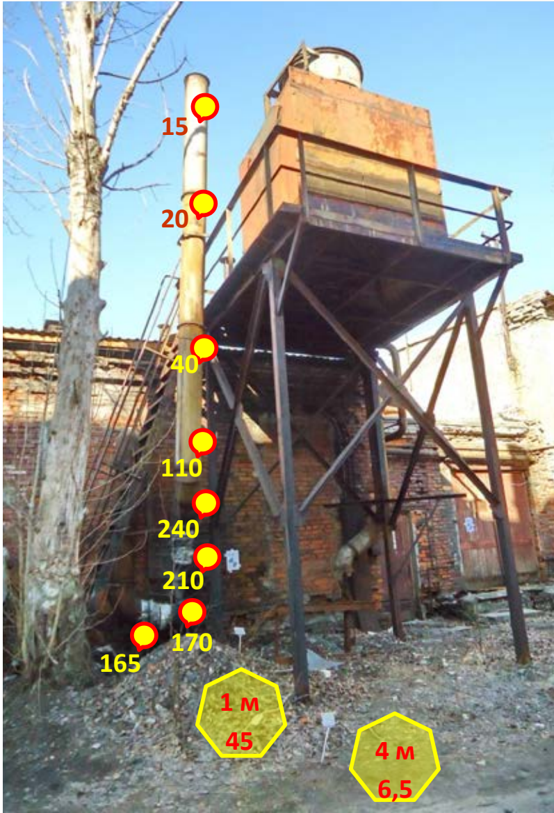
Локальные уровни мощности дозы на системе вытяжной вентиляции доходили до 622 мЗв/ч
