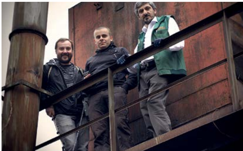
Обследование трубы вытяжной вентиляции аварийного цеха, Е. Л. Серебряков, А. Р. Арутюнян, Р. В. Арутюнян
