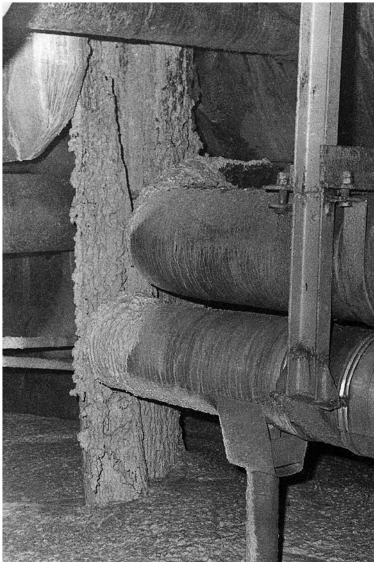
Поврежденная топливом труба на втором этаже бассейна-барботёра. В момент фотосъемки поле внутри трубы — 1200 Р/ч. Гамма-спектрометрия отобранных образцов расплавленного металла показала, что активность металла на 90% определяется изотопами рутения
