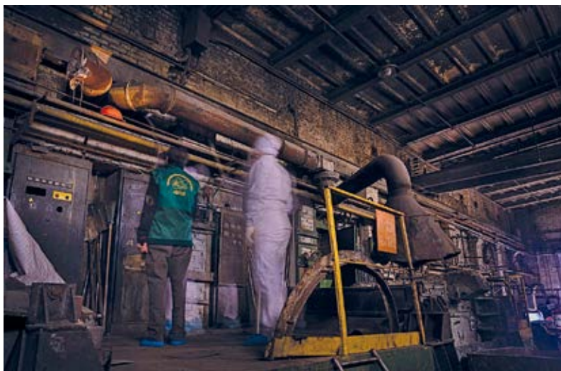
Осмотр вентиляционной системы внутри аварийного здания
