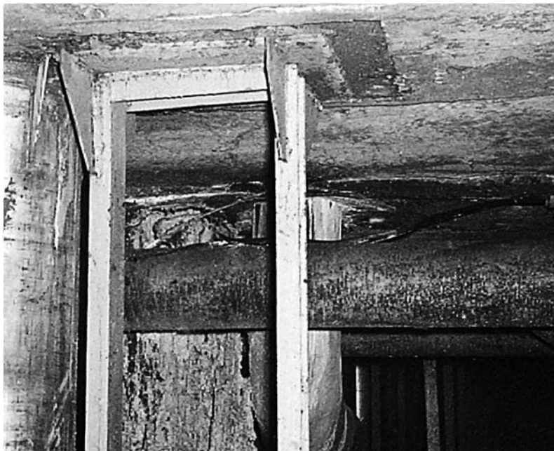
Поврежденные расплавом ядерного топлива металлические конструкции
