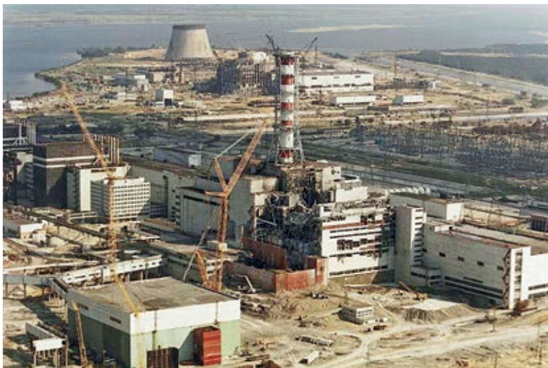
Начало сооружения объекта «Укрытие». Чернобыль, 1986 год
