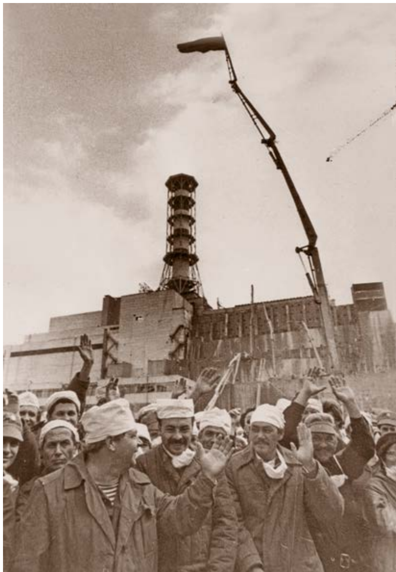
Митинг в честь завершения основных монтажных работ по сооружению Саркофага
